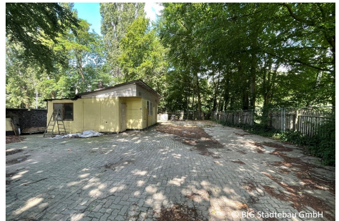
Aus alt und versiegelt wird neu und grün – Startschuss für den Abbruch der Hütte im Herbst 2024
