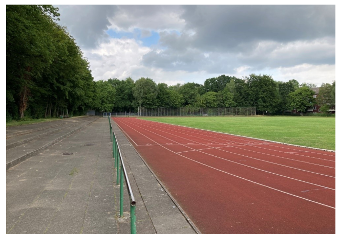
In Vorbereitung: Umnutzung der Traversen durch vielfältige Fitnessangebote für Jung und Alt
