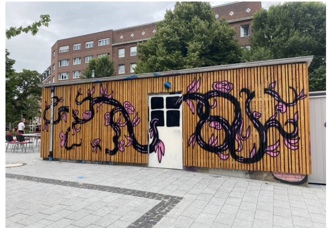
Vandalismusschäden kurz nach der feierlichen Einweihung – nach Fassungslosigkeit folgen kreative Ideen aus dem Stadtteil
