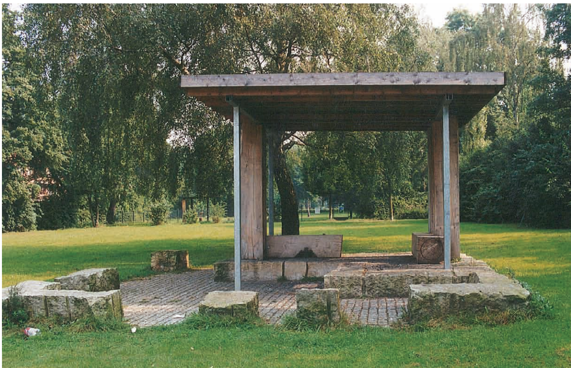
Schluss mit Standardlösungen: Mit hohem Dach und unregelmäßig verteilten Sitzblöcken ist der alte Unterstand am ehemaligen Planschbecken zum „Jugendtreff“ ausgewachsen, 2000
