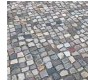
Belag in den Funktionsbändern bzw. -flächen, Granit Naturstein Format 10/10
