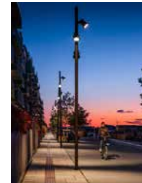
Mastleuchte mit Spots zur breiten Ausleuchtung der Platzfläche, IGUZZINI MaxiWoody
