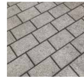
Platzbelag, Großstein 25 x 37,5, Granitvorsatz, Drittelverband
