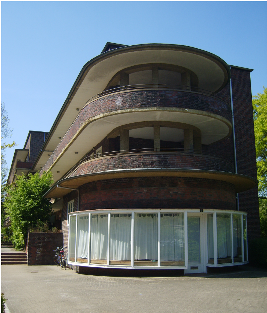
Abbildung 5: Laubengänge der Frankschen Häuser (unsaniertter Zustand)
