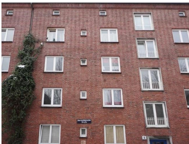
Abbildung 16: Straßenseite der Fassade an Oberschlesische Straße
