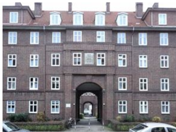
Abbildung 11: Durchgang zum Innenhof
