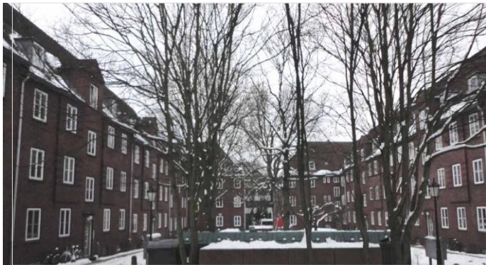
Abbildung 8: Innenhofsituation Olivaer Straße 5
