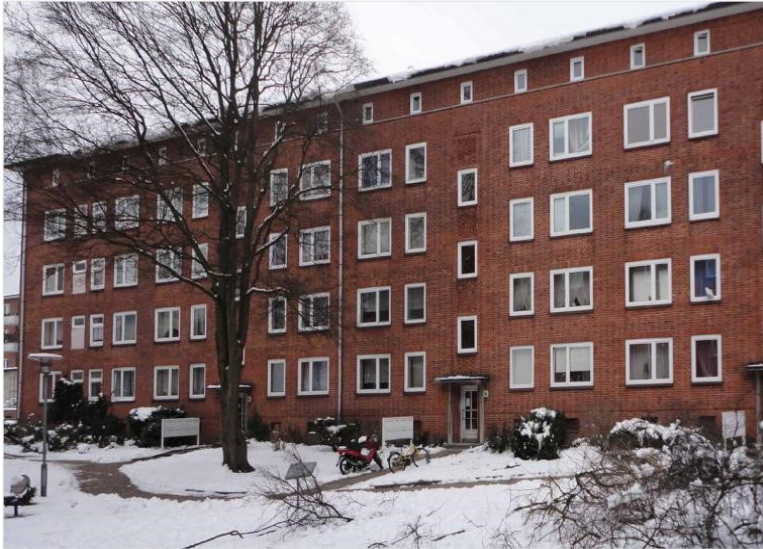
Abbildung 14: Fassade der Eingangseite Nordschleswiger Str.
